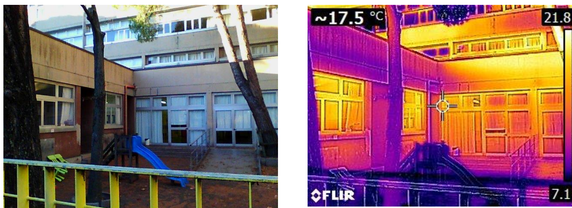
Figura 4.5 – Rilievo termografico dei serramenti
