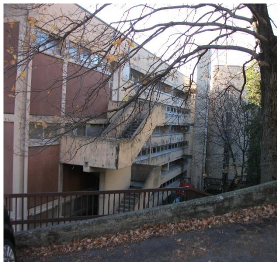
Figura 1.1 - Vista della facciata esposta Nord
