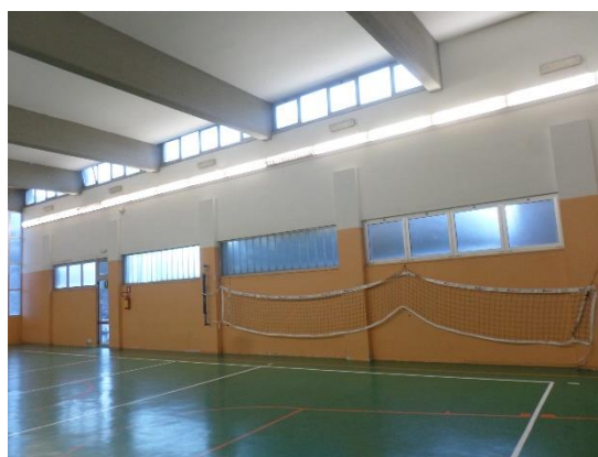
Figura 8.1 – esempio del vecchio tipo di infissi presenti
