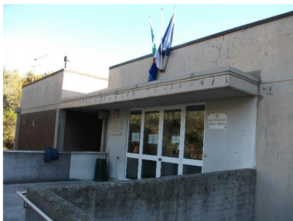
Figura 4.2 - Particolari della facciata
