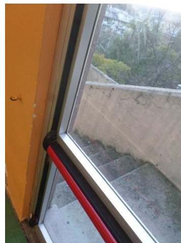
Figura 4.1 - Particolare dell'involucro murario al piano terra
